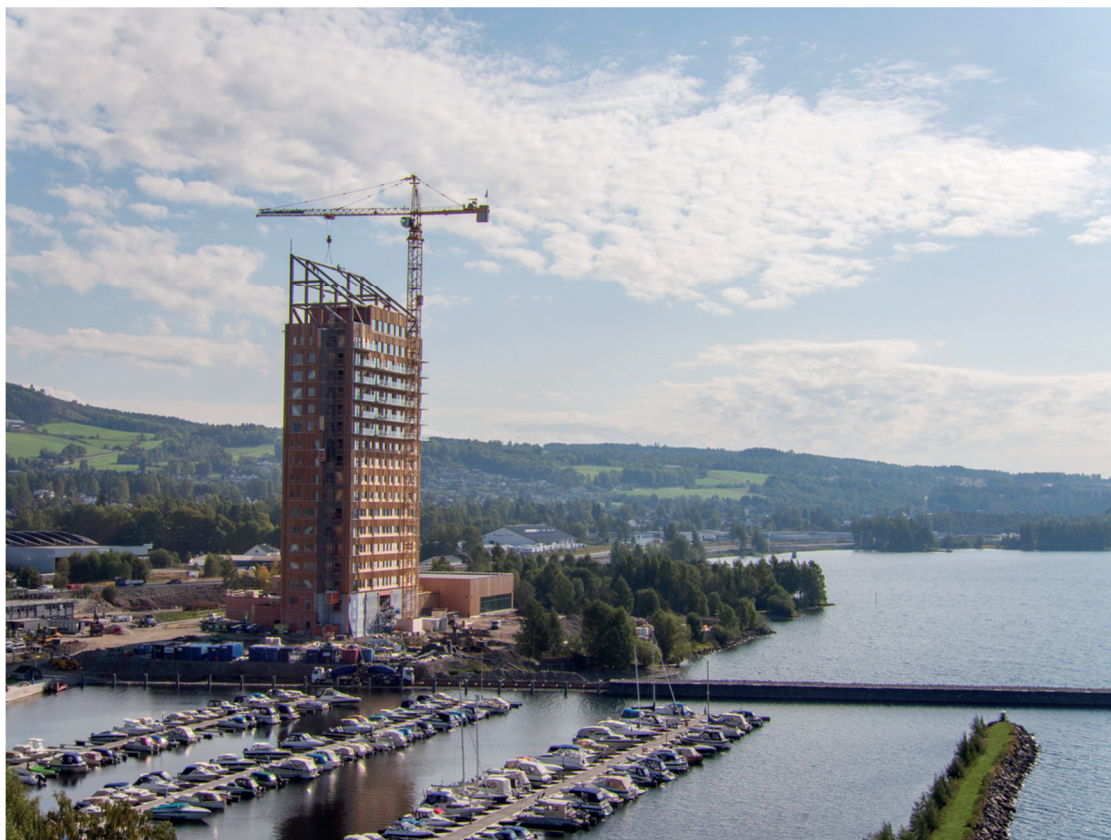
18-etages træhus - Mjøstårnet i Brumunddal Norge. Et eksempel på højt byggeri med træ som bærende konstruktion (illustration: Moelven / fotograf Jens Edgar Haugen)
